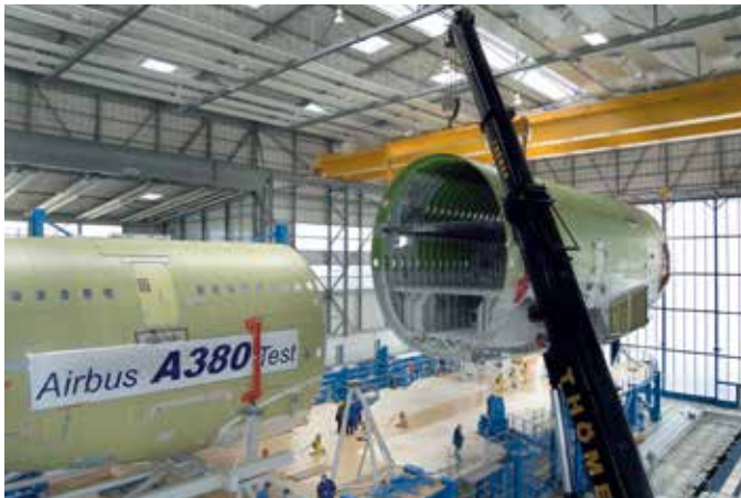
Nicht nur die Abmessungen des neuen Airbus 380 sind extrem. Für die knapp 30 Meter hohe Haupthalle fertigte Zehnder Deckenstrahlplatten mit einer Baulänge von jeweils 68 Metern.
