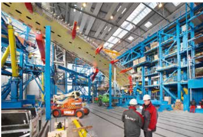
Energieeffizientes Beheizen einer Großanlage: Auch bei fast 30 Metern Hallenhöhe lässt sich mit den Strahlplatten sehr ökonomisch eine homogene Raumtemperatur erreichen.
