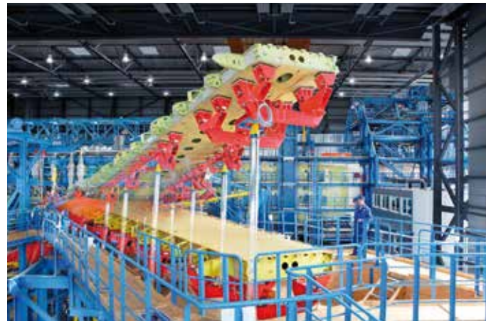
Zahlreiche Installationen auf dem Boden der Testhalle machten die Alternative einer Fußbodenheizung praktisch unmöglich. Deckenstrahlplatten hingegen erfüllen alle Anforderungen an Platzersparnis, wirtschaftlicher Effektivität und Heizergebnis.
