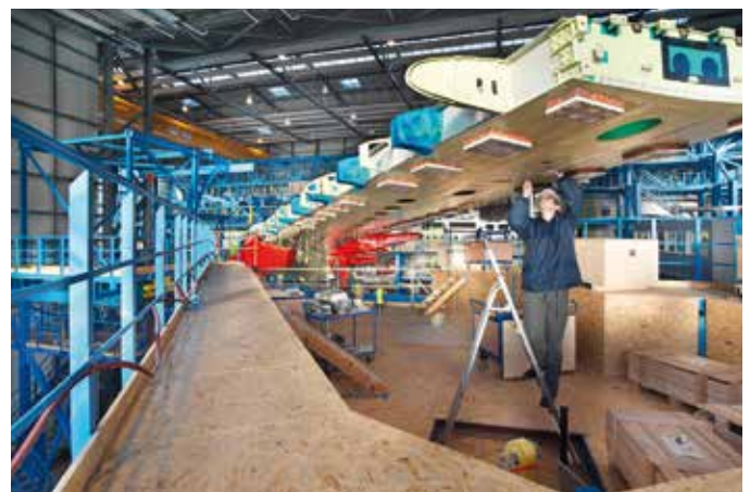
In der Versuchshalle waren wegen der äußerst sensiblen Messprozesse am Airbus 380 ungewöhnlich hohe Temperaturen von 20°C gefordert. Deshalb wurden zur Beheizung ausschließlich Deckenstrahlplatten eingesetzt, deren Energiespareffekte bei diesen Temperaturanforderungen voll zum Tragen kommen.
