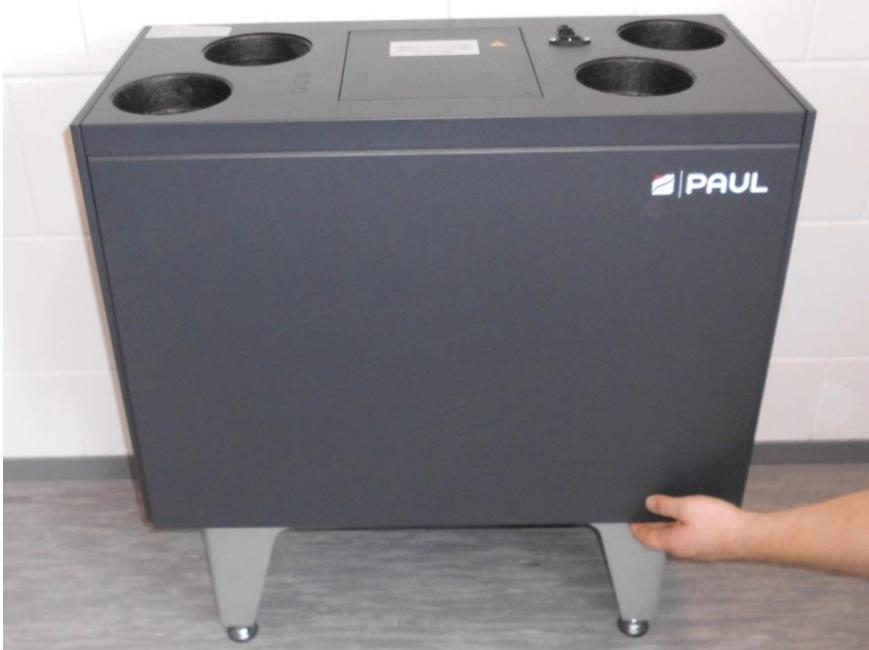
4. Hebeln Sie mit Hilfe einer Spachtel die EPP-Ventilatorabdeckung aus den Gehäuse.
