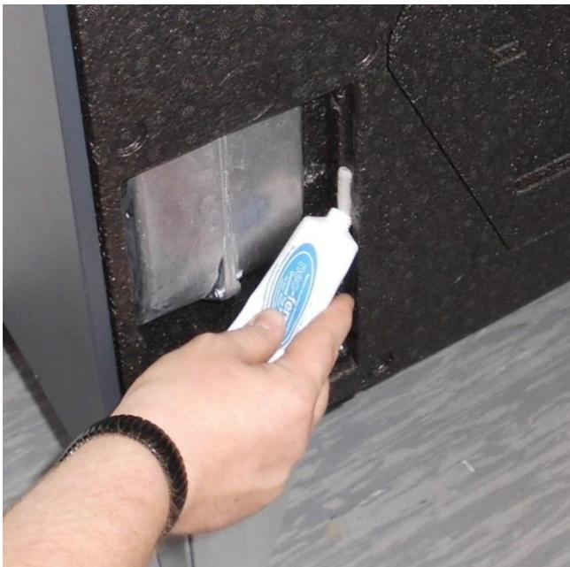
11. Setzen Sie die EPP-Ventilatorabdeckung in das Lüftungsgerätes ein und entfernen Sie die überschüssige Dichtmasse.
