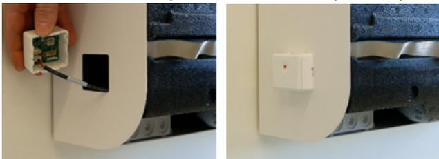
Vuelva a montar el aparato de ventilación según la instrucción de montaje correspondiente. A continuación vuelva a establecer el suministro de tensión y realice una prueba de funcionamiento.
