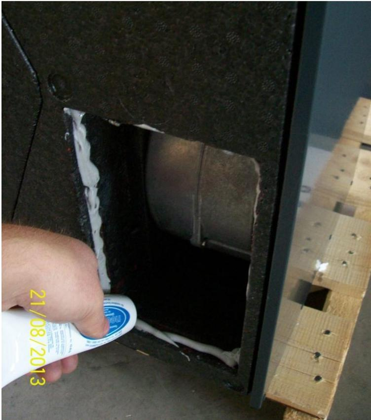
11. Setzen Sie die EPP-Ventilatorabdeckung in das Lüftungsgerätes ein und entfernen Sie die überschüssige Dichtmasse.
