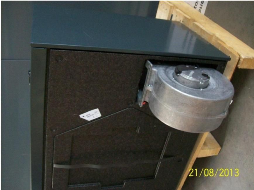
8. Stecken Sie den Stecker auf den Ventilator und befestigen Sie ihn mit den zugehörigen Torxschrauben.
