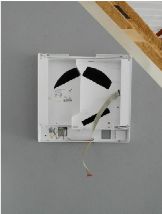
8. Lösen Sie die Schraube zur Fixierung des Gerätes an der Wand.
