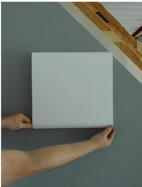
4. Greifen Sie mit dem Finger seitlich zwischen den Filterverschluss aus Zellkautschuk und der Filterfachöffnung der Unterschale Innenhaube und ziehen den Außenluftfilterverschluss heraus.
