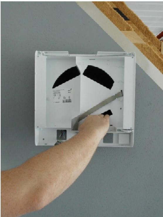
10. Trennen Sie das Flachbandkabel von der Platine der Bedienfolie. Entnehmen Sie das Flachbandkabel den Kabelfixierungen und führen Sie es bis zur Durchführung in die Innenhaube Unterschale zurück.
