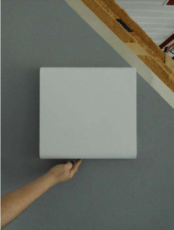
2. Nehmen Sie die obere Design-Abdeckhaube ab, indem Sie die beidseitig vorhandene 2-fache Rastverbindung zwischen Unter- und Oberschale der Innenhaube entweder an der oberen oder unteren Rundung (je nach besserer Zugänglichkeit) austrasten.
