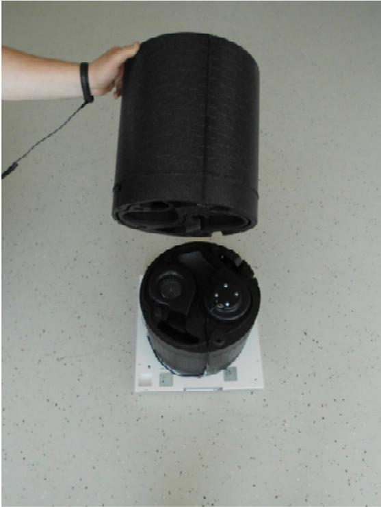
15. Ziehen Sie den Abluftventilator aus dem EPP-Gehäuse.
