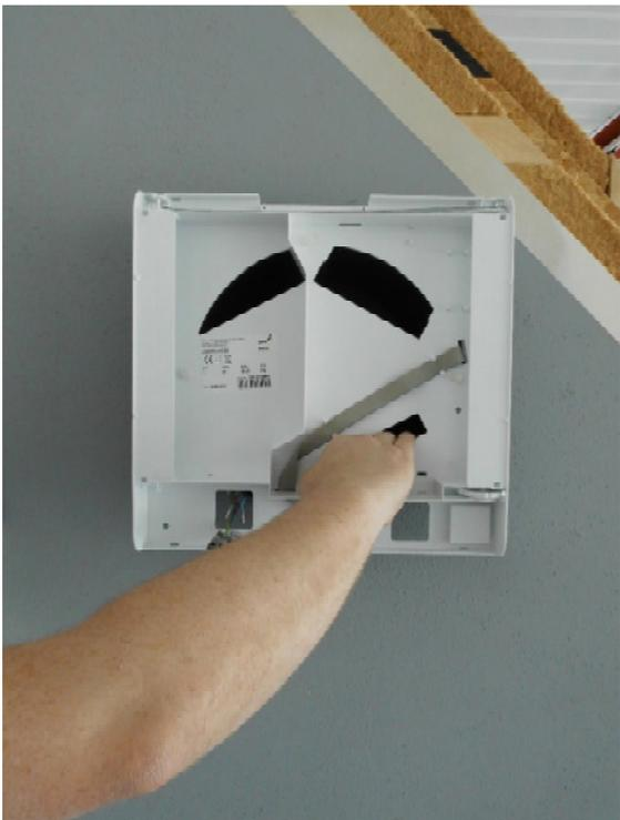
10. Hebeln Sie vorsichtig mit einem Schraubendreher die Elektroabdeckung aus dem EPP Gehäuse.
