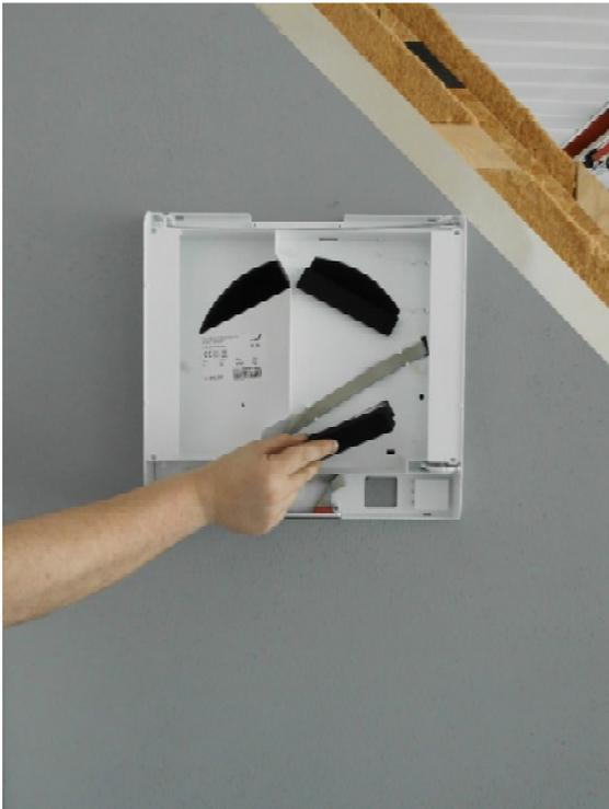
5. Ziehen Sie den Außenluftfilter, an den Zuglaschen fassend, vorsichtig aus dem Filterfach.
