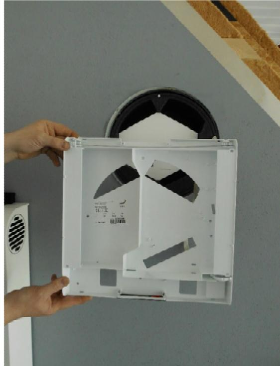
10. Der Enthalpiewärmetauscher kann nun aus dem Gerät herausgezogen und ausgetauscht werden.
