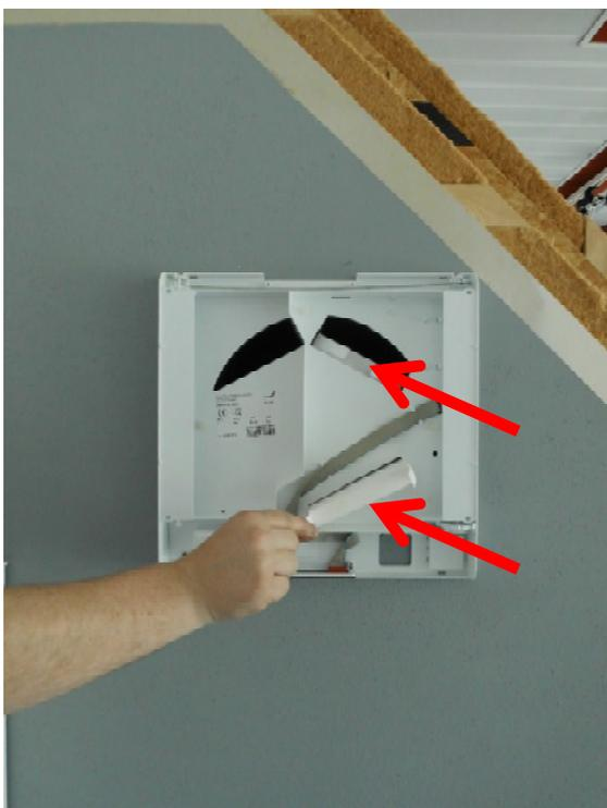
6. Lösen Sie die Schraube zur Fixierung des Gerätes an der Wand.
