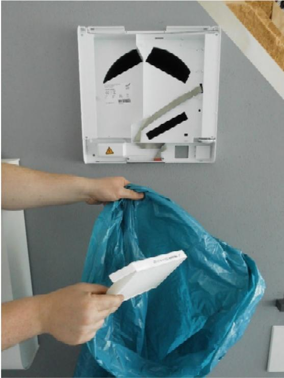
6. Setzen Sie den neuen Filter ein. Achten Sie darauf, dass die Filter nicht mit Gewalt in das Gehäuse gedrückt werden.
