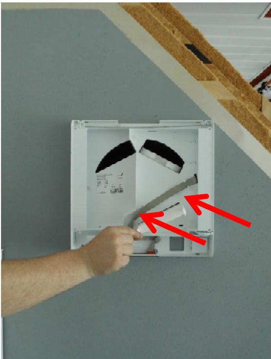
5. Verpacken Sie die Filter in einem dichten Beutel und führen Sie diese dem Restmüll zu.
