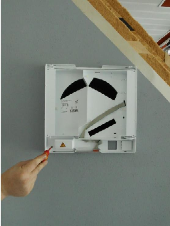
7. Lösen Sie die vier Mutter für die Befestigung der Elektroabdeckung und nehmen diese ab.
