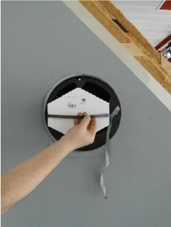
11. Montieren Sie alle Teile in umgekehrter Reihenfolge. Der Aufkleber des Enthalpiewärmetauschers muss sich oben befinden.
