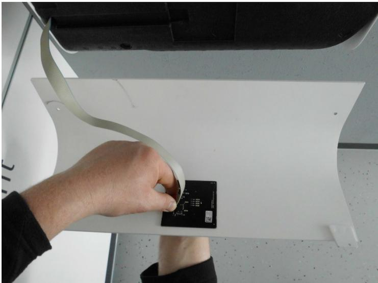
6. Ziehen Sie das Gerät vorsichtig etwas aus dem Wand-Einbaurohr heraus. Achten Sie darauf, dass das Netzkabel und das Kabel für die Bedieneinheit keinen Schaden nehmen.
