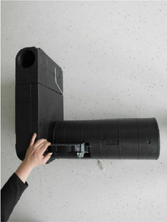
13. Demontieren Sie die Klappeneinheit.
