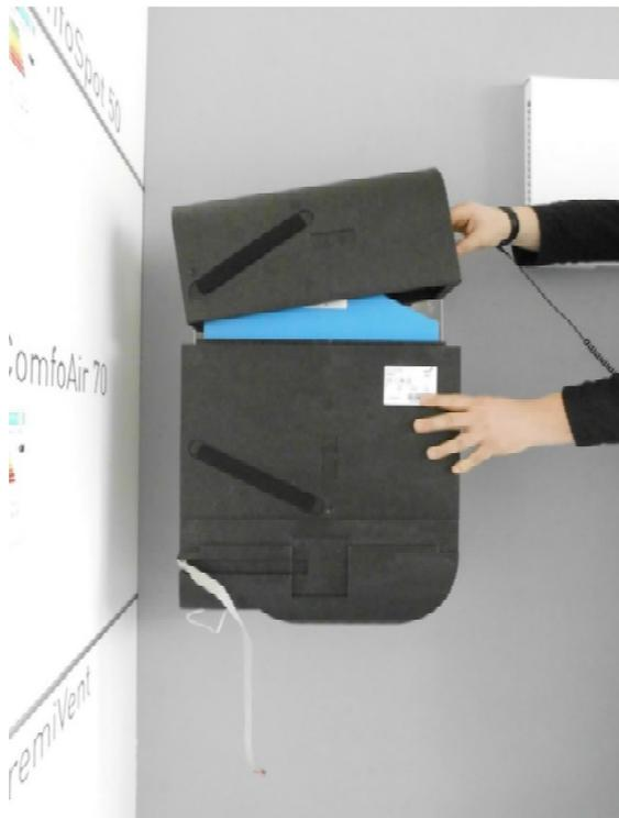
9. Platzieren sie den oberen Teil des EPP-Gehäuses hinter dem Gerät.
