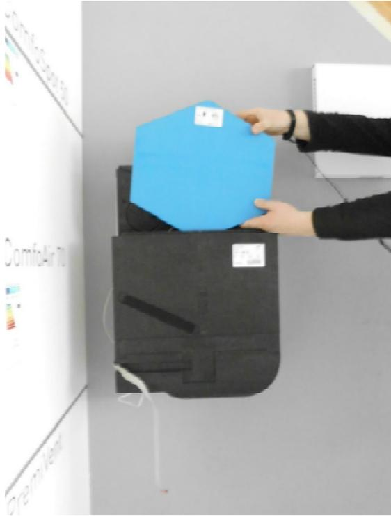
11. Montieren Sie alle Teile in umgekehrter Reihenfolge. Der Aufkleber des Wärmetauschers muss sich oben befinden.
