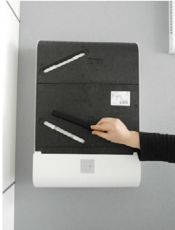
4. Ziehen Sie den Filter vorsichtig an den Zugbändern fassend aus dem Filterfach.
