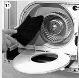
11 Bürsten Sie das Gehäuse und den Ventilator mit einer weichen Bürste ab.
