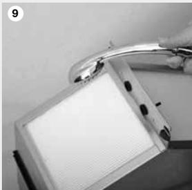
9 Spülen Sie den Wärme- / Enthalpietauscher mit lauwarmen (max. 40°C) Wasser ab. Anschliessend schütteln Sie den Wärme- / Enthalpietauscher aus, bis kein Wasser mehr heraus tropft.
