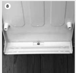
8 Prüfen und reinigen Sie den Kondensatablauf und den externen Siphon.
